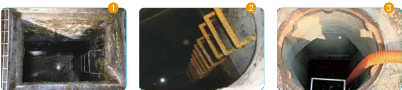
하수처리장 저류조/농어촌 하수로/상수도 배관 내부 등
